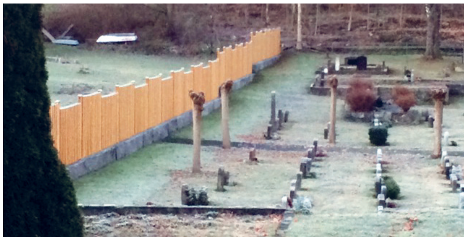
Nytt plankegjerde satt på steinblokker
